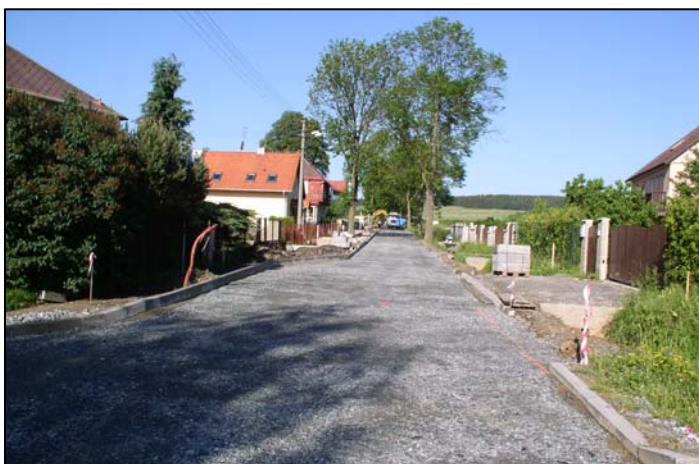
Silnice v ulici K Malé Hleděsebi po položení štěrkové vrstvy (20.6.2006)
